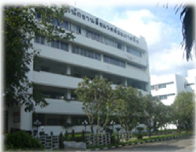
อาคารสำนักงานสิ่งแวดล้อม ภาคที่ 6 นนทบุรี
